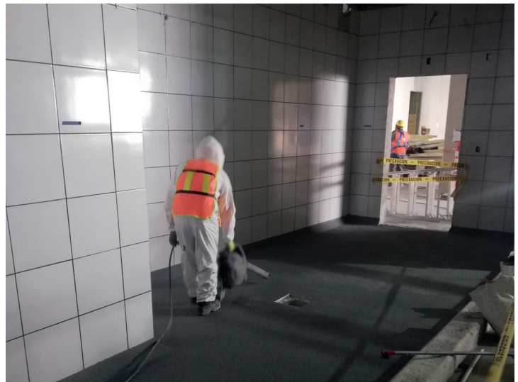
Aplicación del Sistemas Flowcrete
